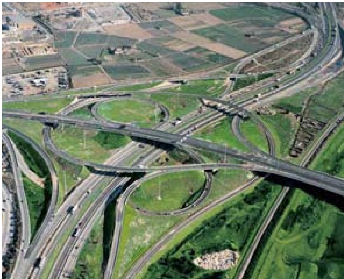
Prolongación del segundo cinturón de Barcelona, Pata Sur
