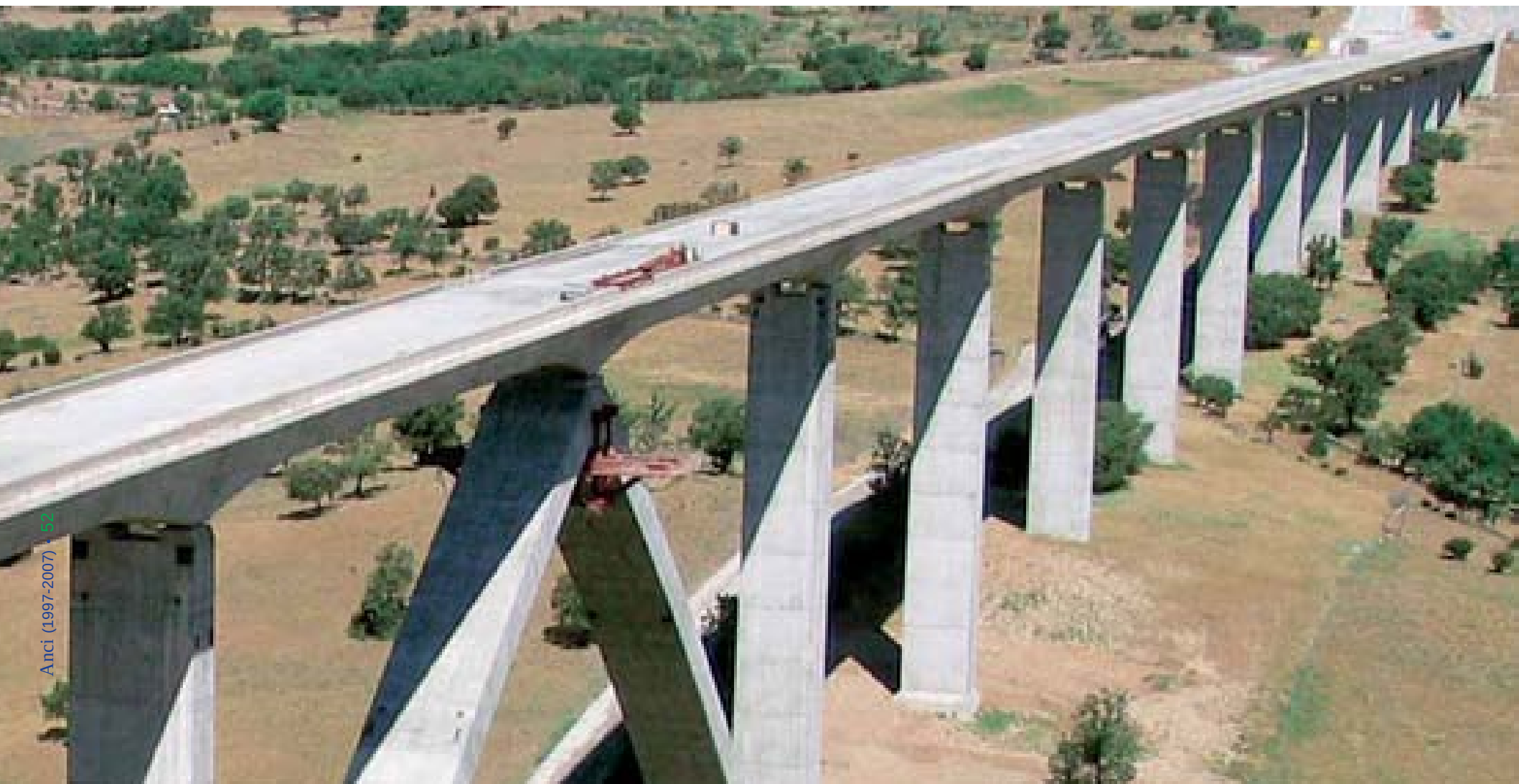
Acceso Ferroviario al norte y noroeste de España. Tramo Soto del Real-Miraflores de la Sierra. Madrid. (UTE con Puentes y Calzadas)
