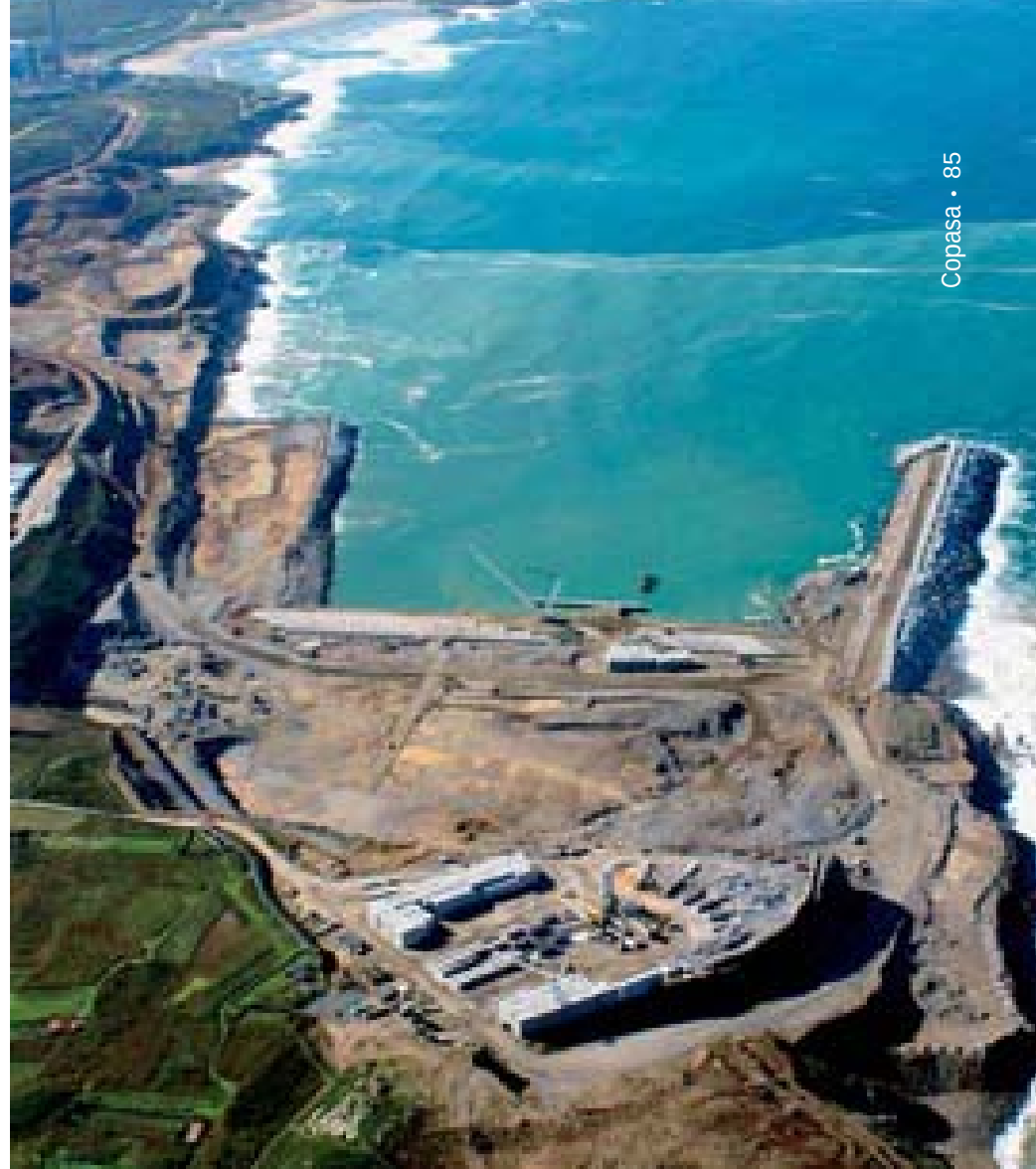
Obras del puerto exterior en Punta Langosteira. A Coruña
