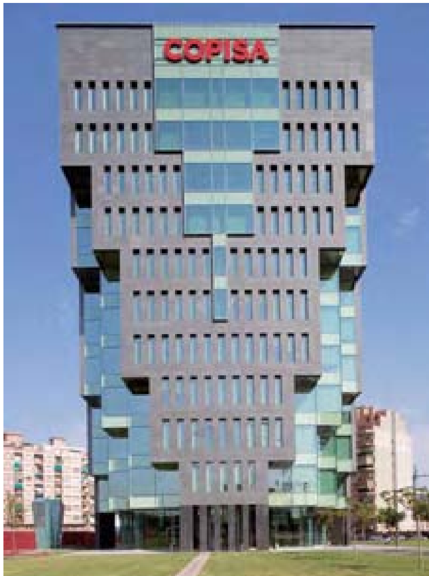
Torre Copisa. L'Hospitalet de Llobregat. Barcelona
