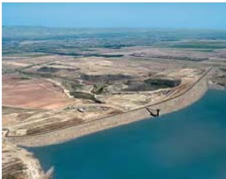
Presa de La Loteta, reguladora del Canal Imperial de Aragón. Zaragoza
