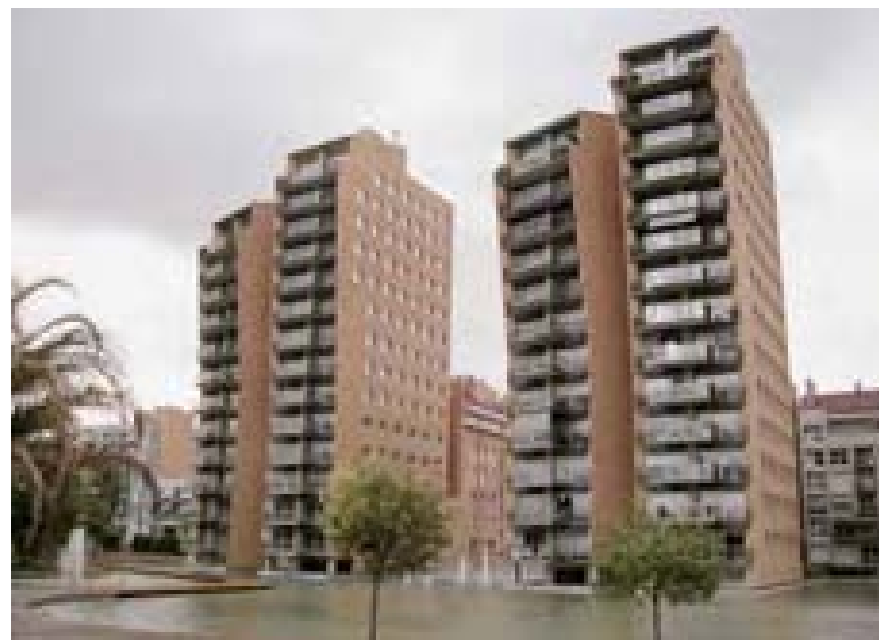
Construcción de 470 viviendas, aparcamientos y locales en los antiguos cuarteles de Girona. Girona
