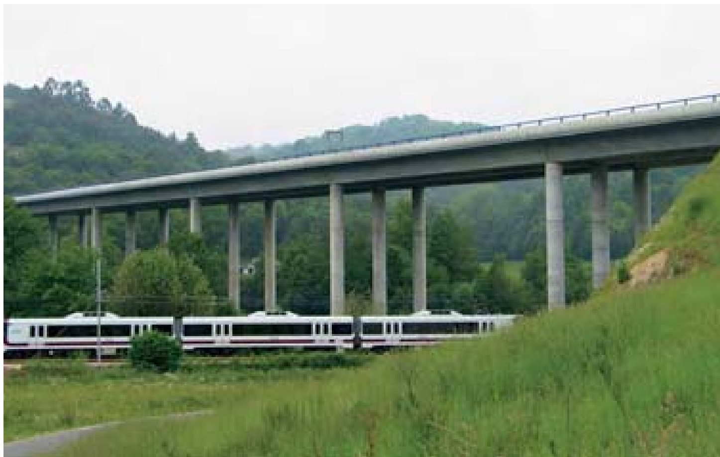
Autovía Mieres-Gijón. Autovía Minera. Asturias
