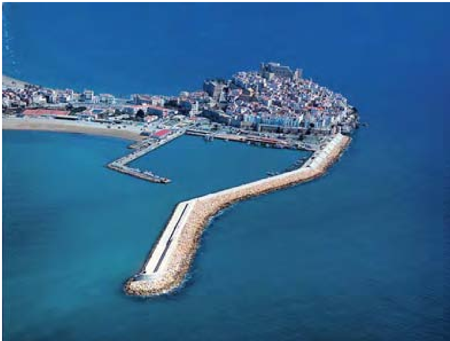
Dique de Levante en Peñíscola. Castellón
