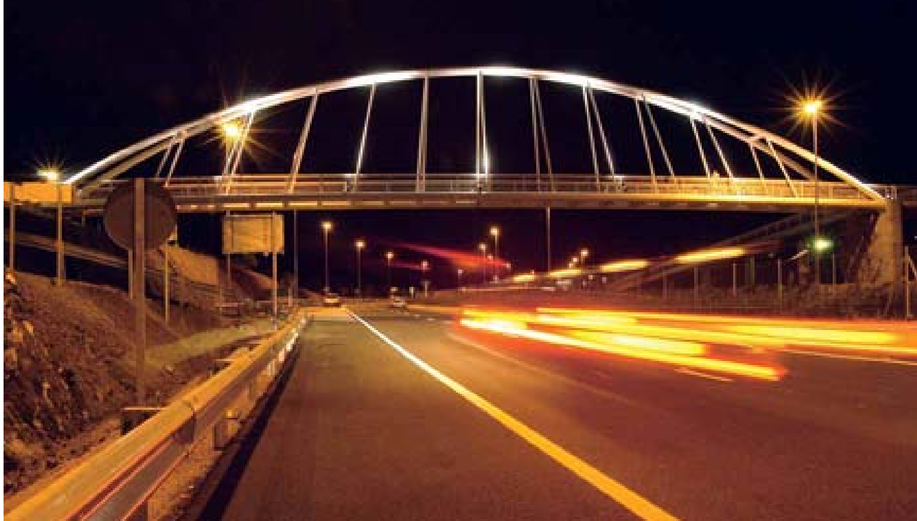
Ronda Norte de Cáceres. Tramo 1. Cáceres
