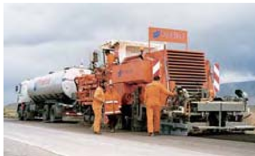
Rehabilitación de varios tramos de la A-92
