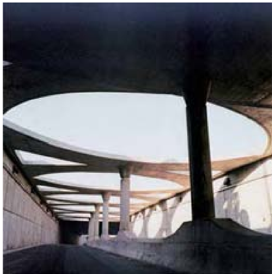
Falso túnel de Acceso a Bouzas. Vigo. Pontevedra
