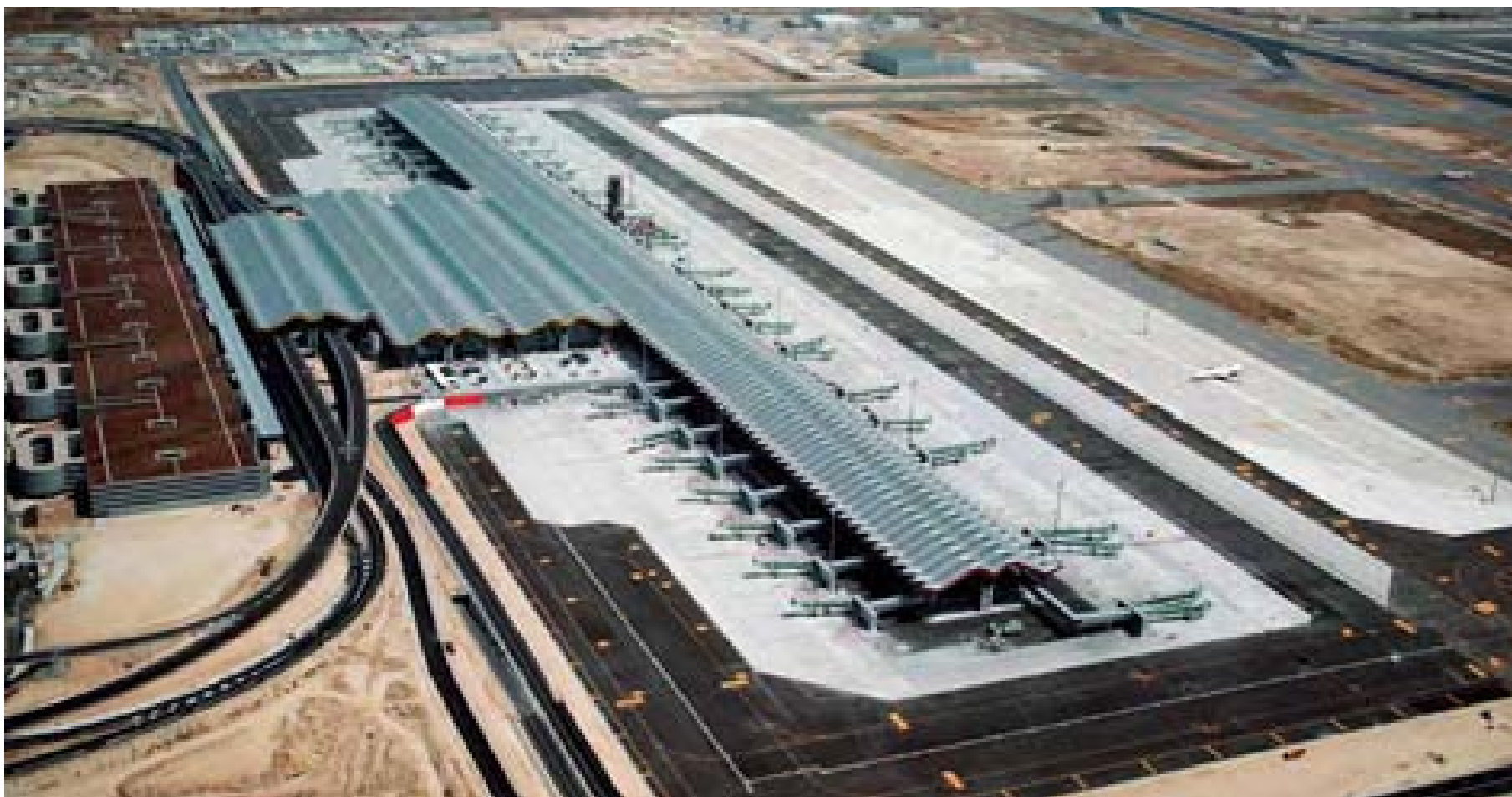
Plataforma del Dique Zona Oeste. Nueva Terminal del Aeropuerto de Barajas. Madrid (UTE)
