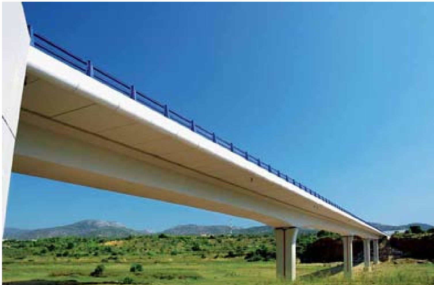
Acueducto sobre el embalse de M a Cristina. Alcora, Castellón
