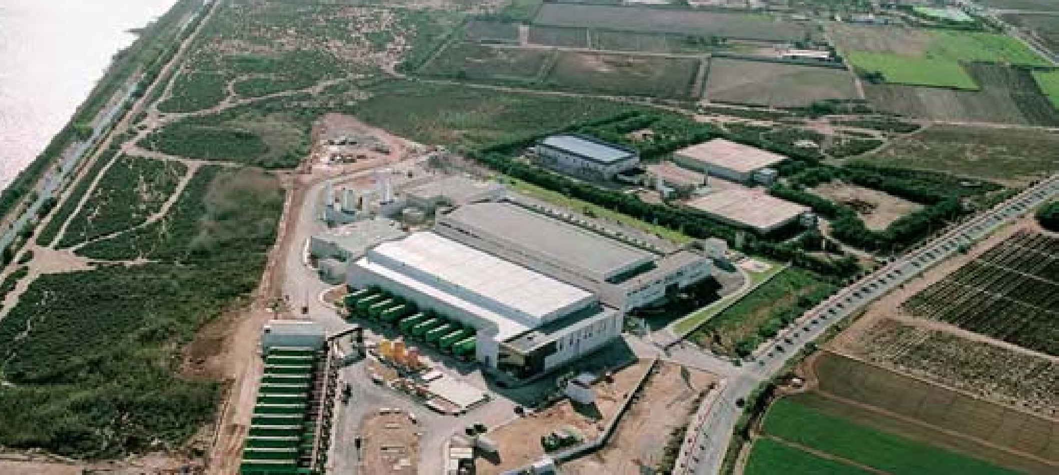
Nueva desaladora del nuevo Canal de Cartagena. San Pedro del Pinatar II. Murcia
