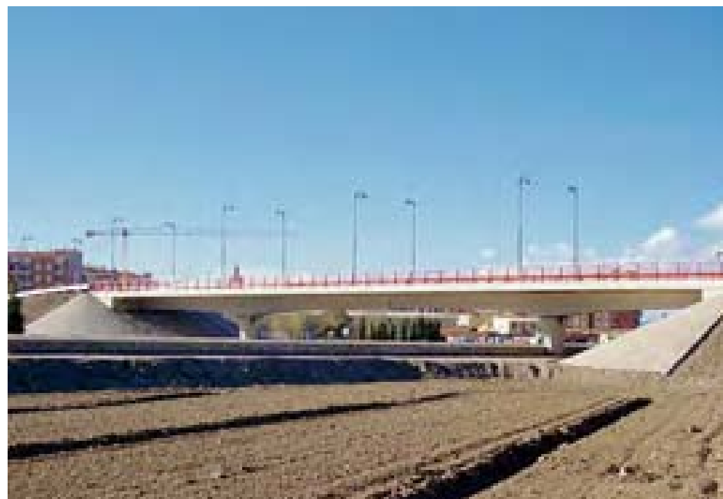
Puente sobre la Rambla del Patrón en Fíñana. Granada
