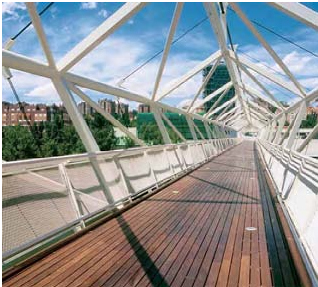
Pasarela sobre el río Pisuerga. Valladolid
