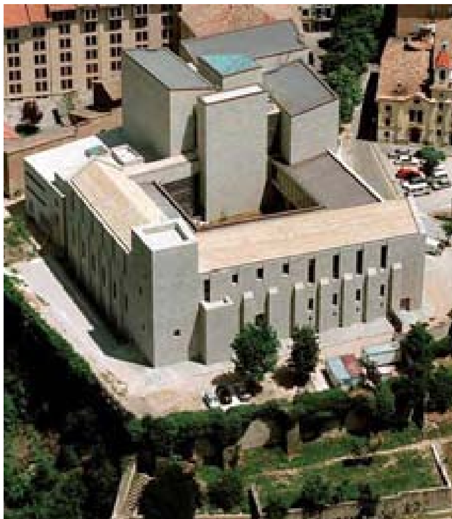
Rehabilitación del Palacio de Capitanía. Pamplona
