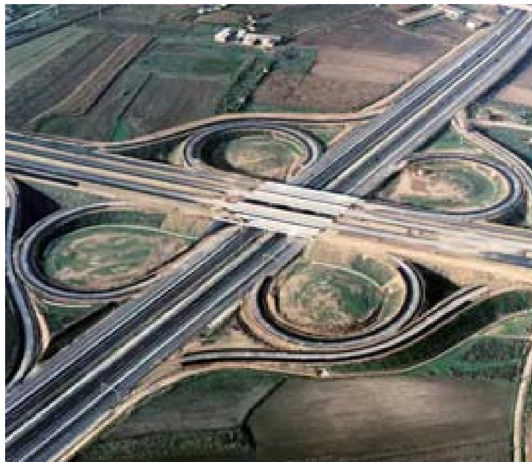
Autovía Ruta de la Plata A-66. Tramo Zamora Norte-río Duero. Zamora
