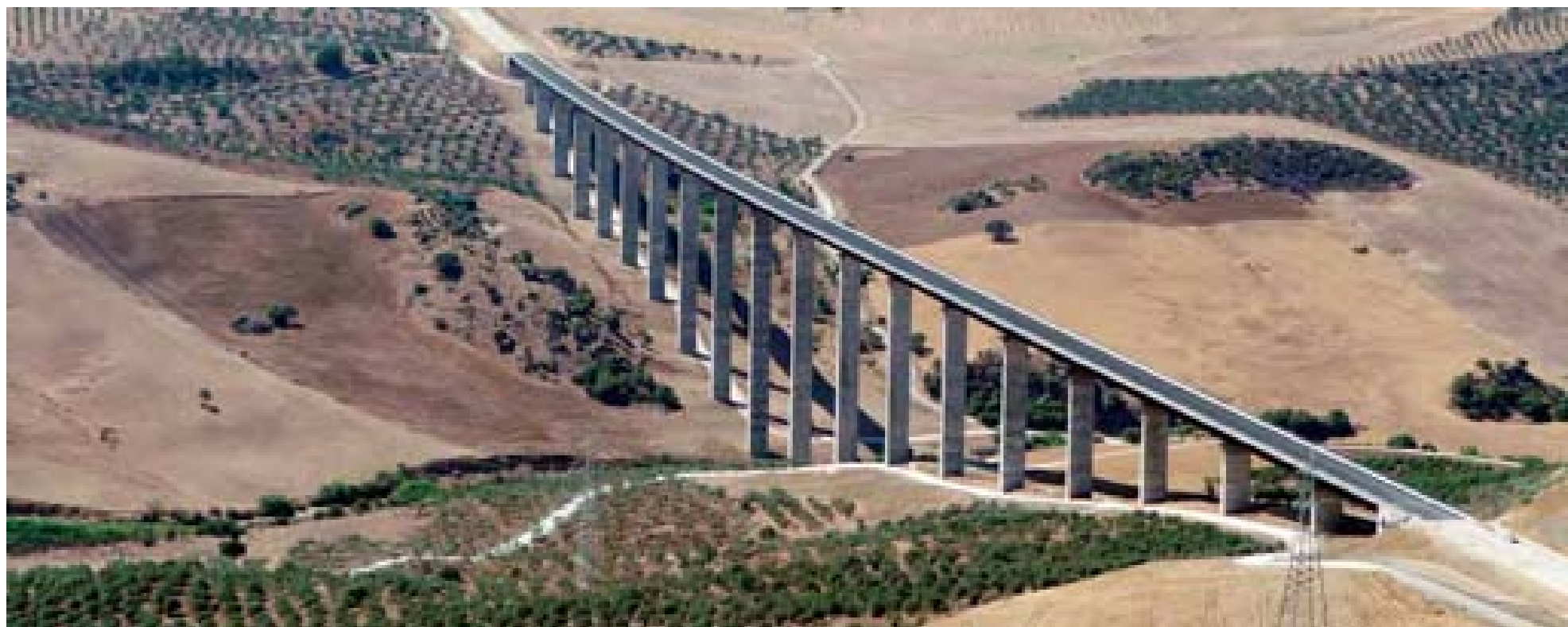
Viaducto sobre el Arroyo de las Piedras. Málaga
