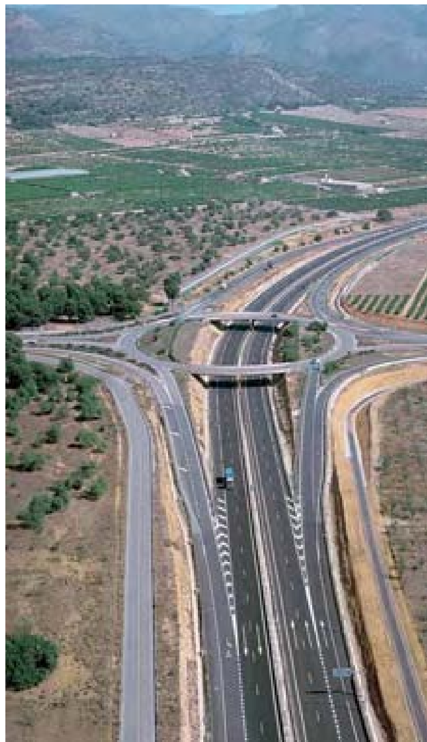
Autovía la Plana. Tramo Betxí-Borriol. Castellón (UTE)
