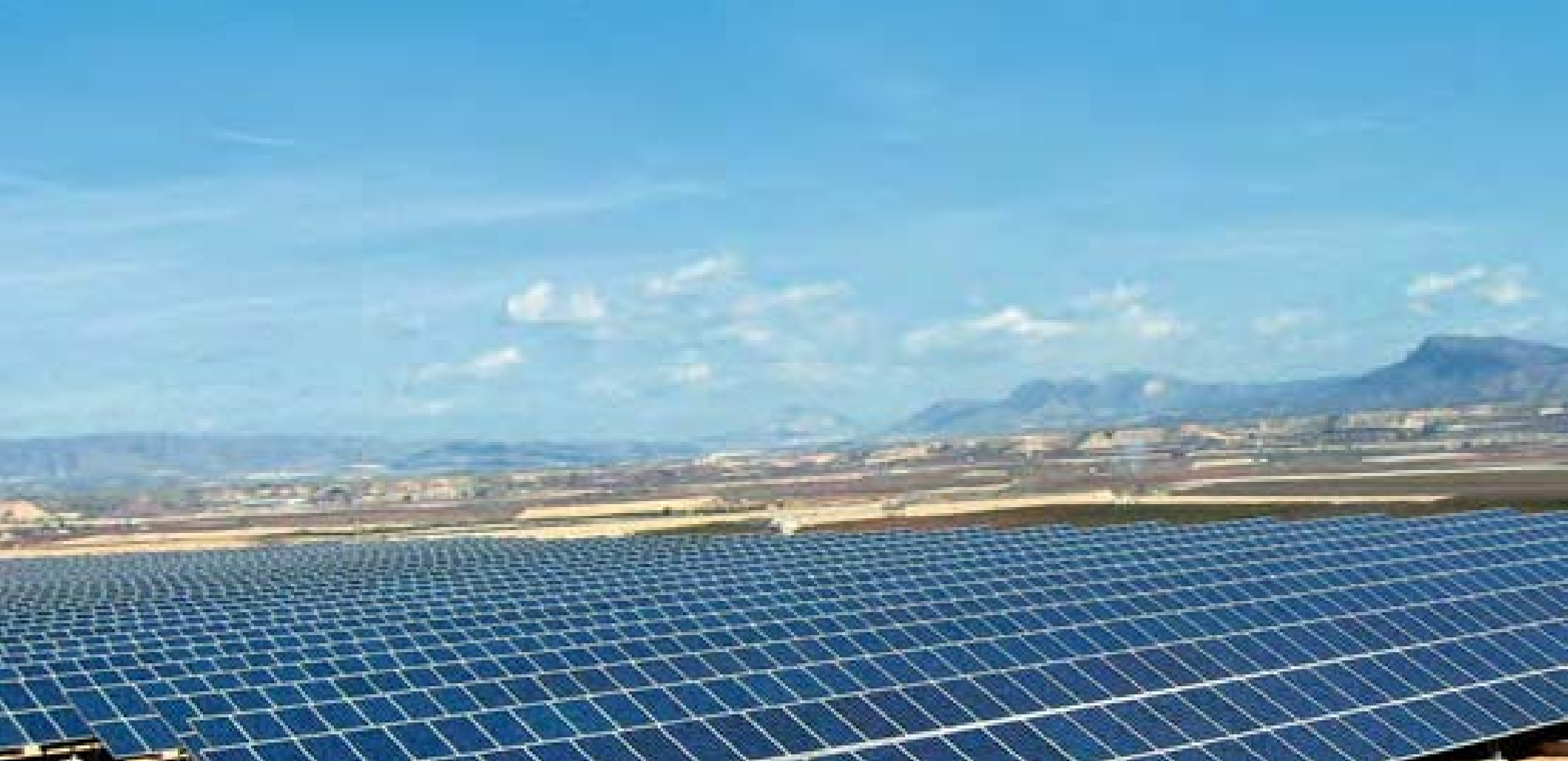
Planta solar fotovoltaica El Solivar en Cieza. Murcia
