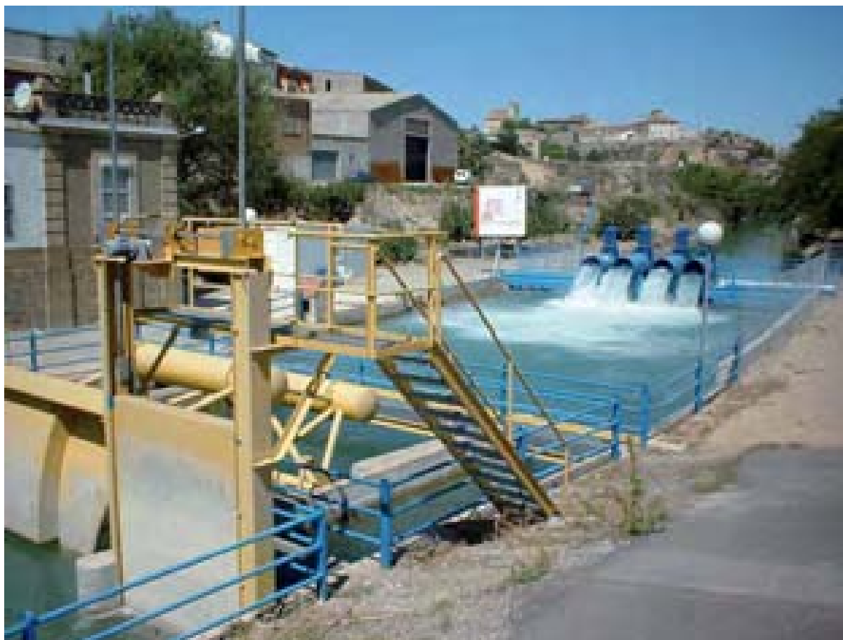
Obras de emergencia. Bombeos Canal de Aragón y Cataluña
