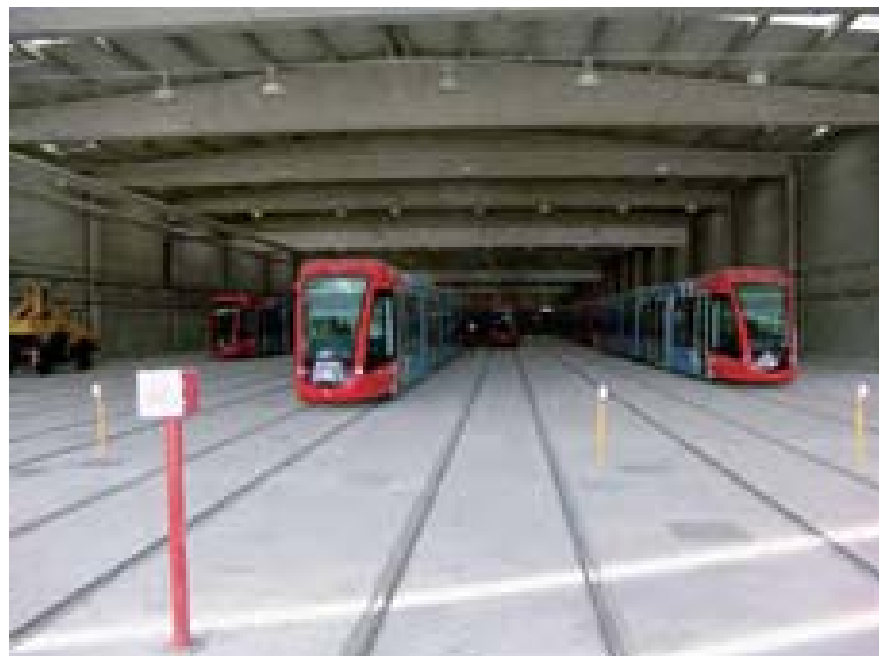
Talleres y cocheras del Metro Ligero. Madrid
