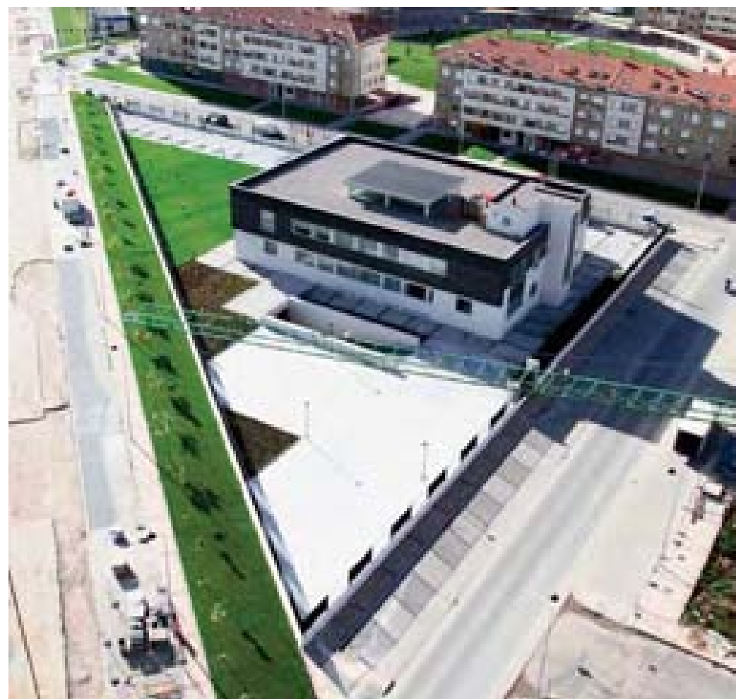
Edificio de la sede de la Federación de Fútbol de Castilla y León. Valladolid
