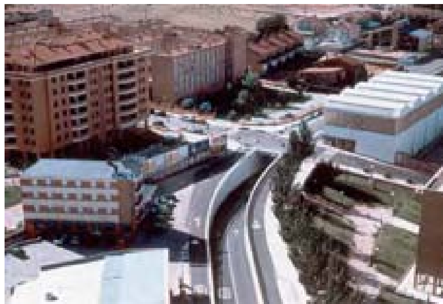
Construcción de paso inferior en la CN-111 y acondicionamientos de accesos a Soria
