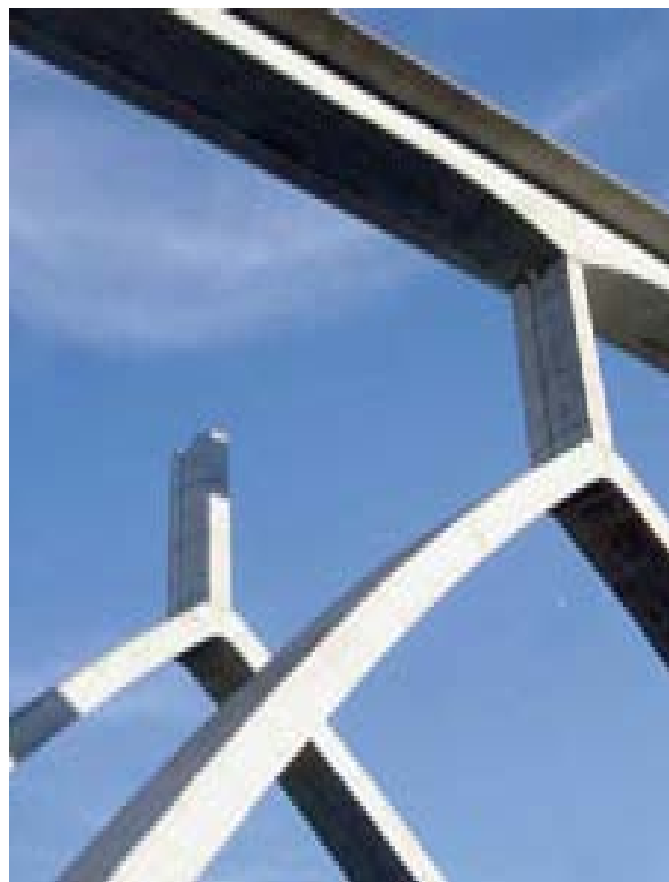
CN-340 Variante de Almuñécar. Detalle del viaducto (UTE con Azvi)
