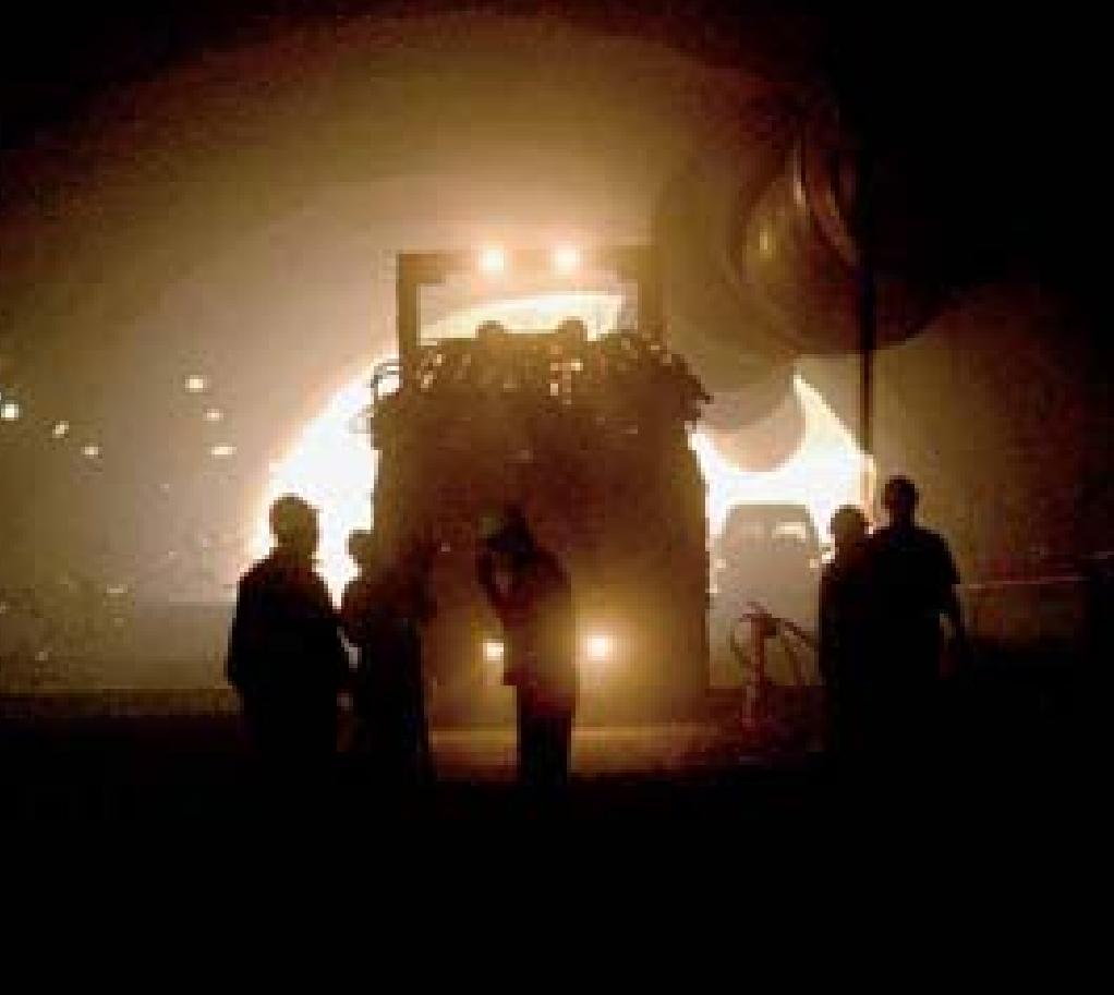
Túnel de Énova de Alta Velocidad Xàtiva-Valencia. Valencia (UTE con Ploder)
