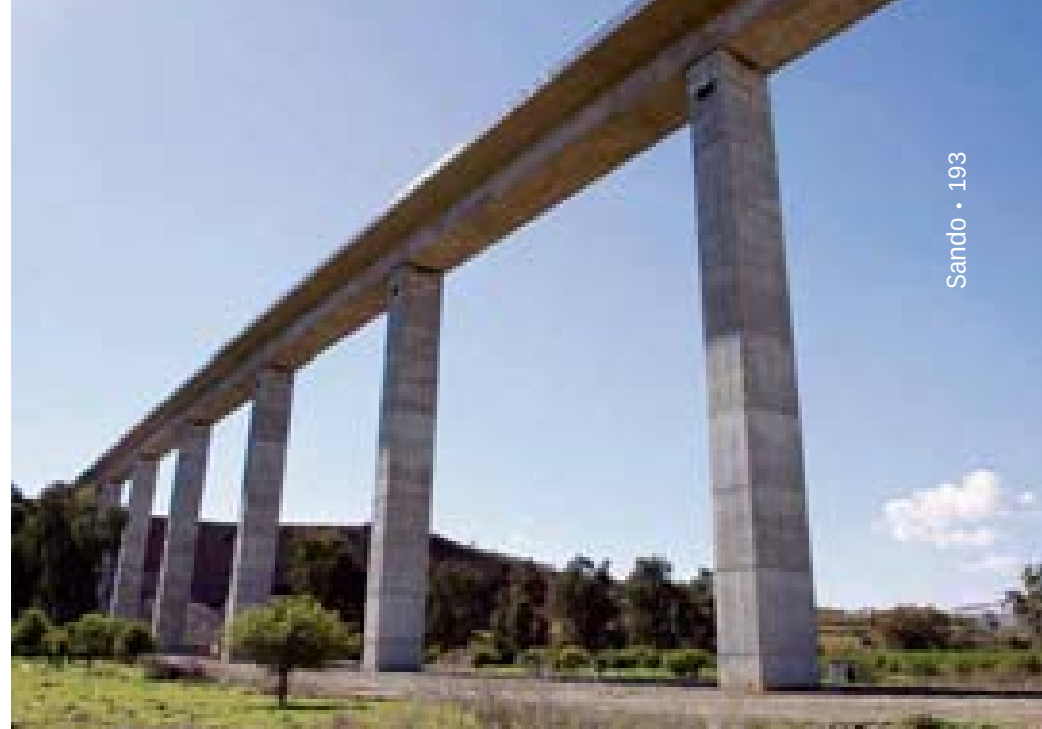
Viaductos de El Espinazo y Jévar. Málaga
