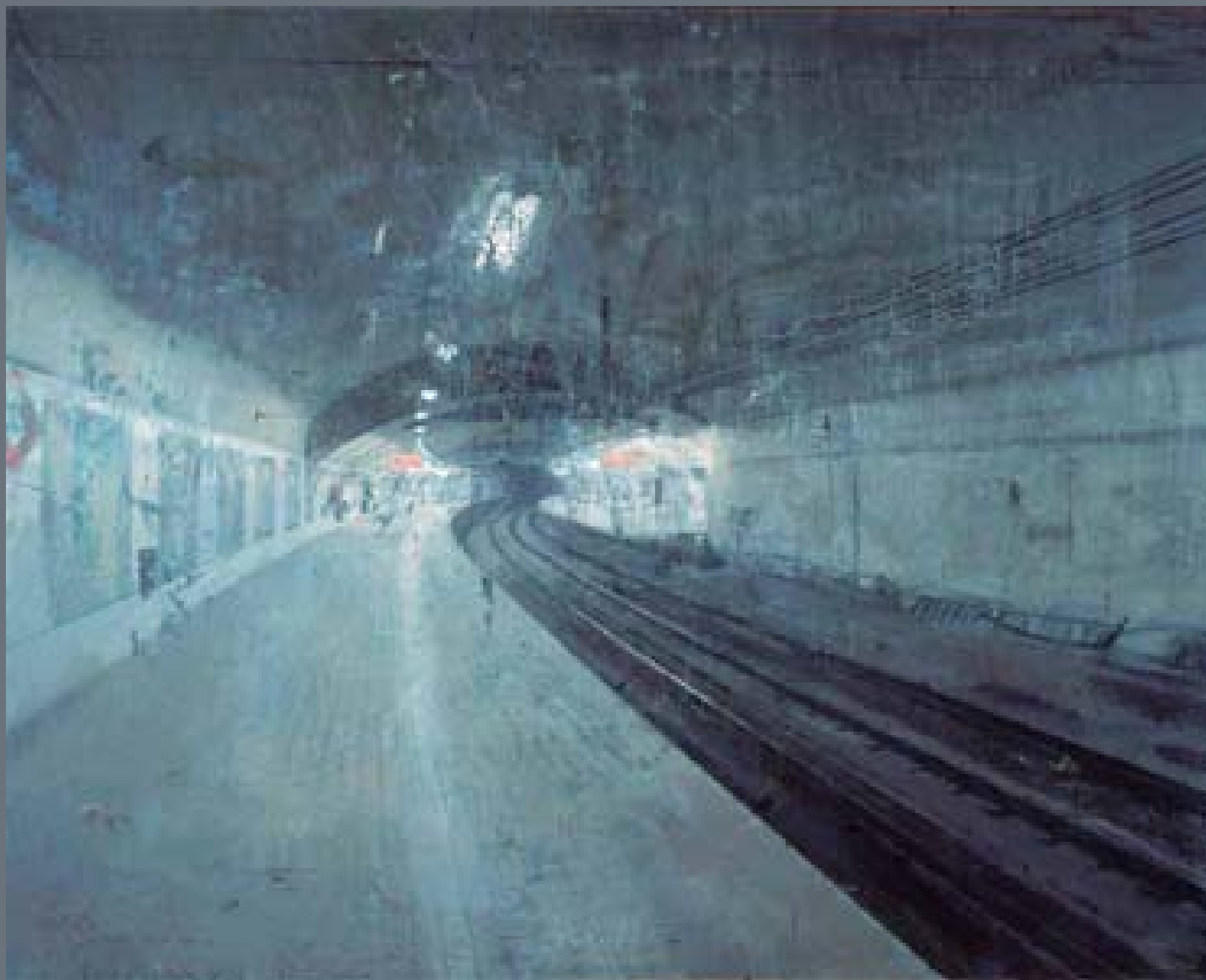
Estación de Metro
