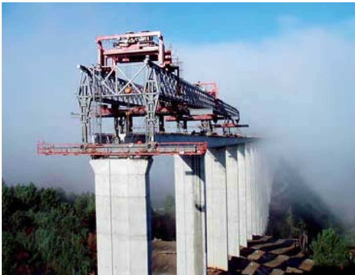
Autovía Ferrol-Villalba. Viaducto sobre el río Eume. A Coruña
