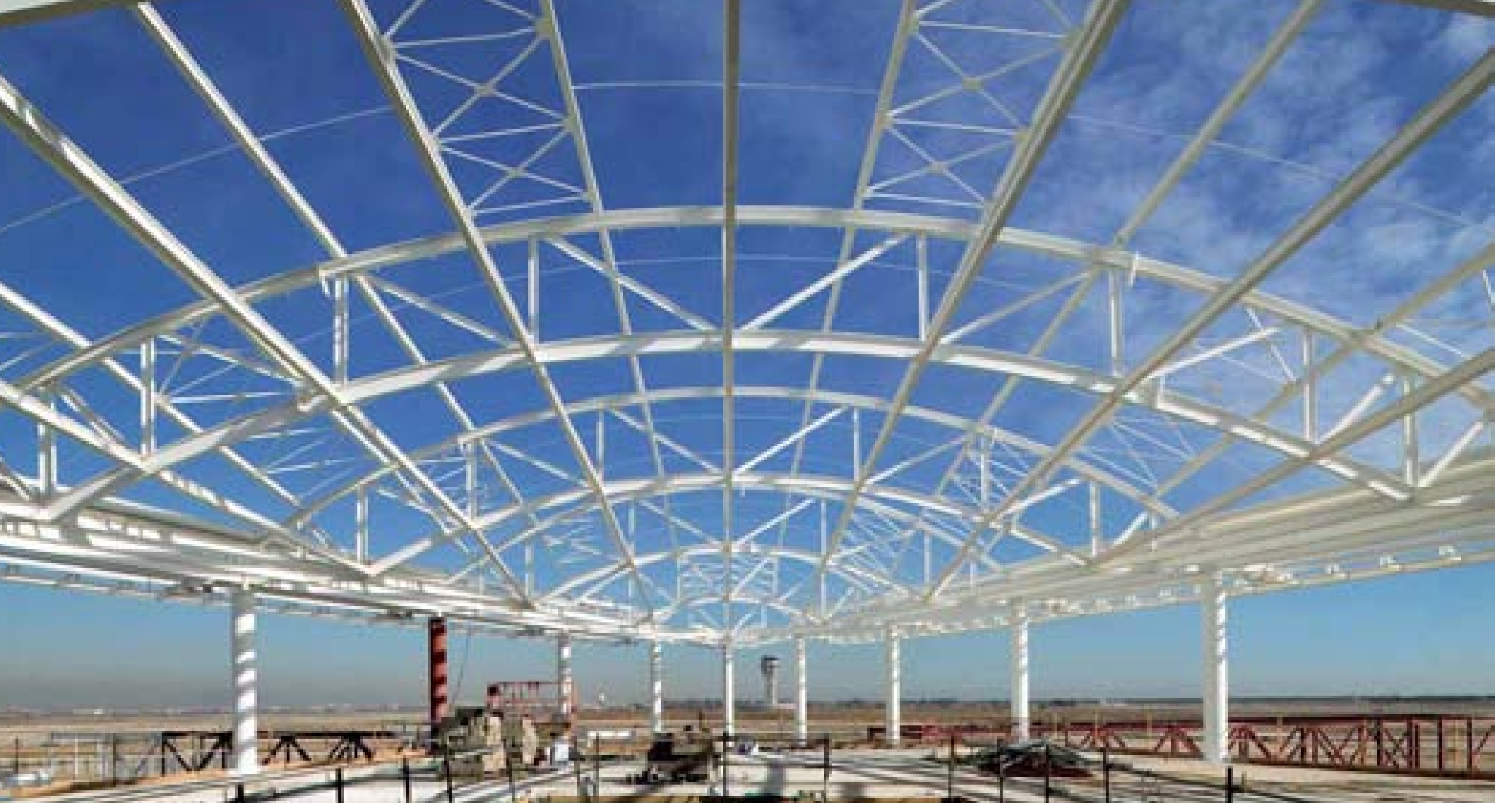
Terminal Sur del Aeropuerto de El Prat. Barcelona
